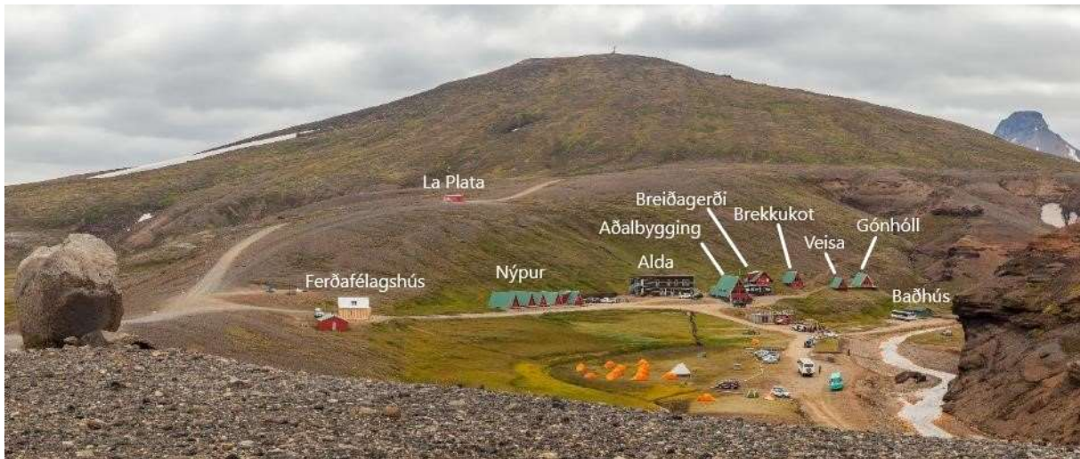
MYND 2.7 Núverandi mannvirki í Ásgarði.
